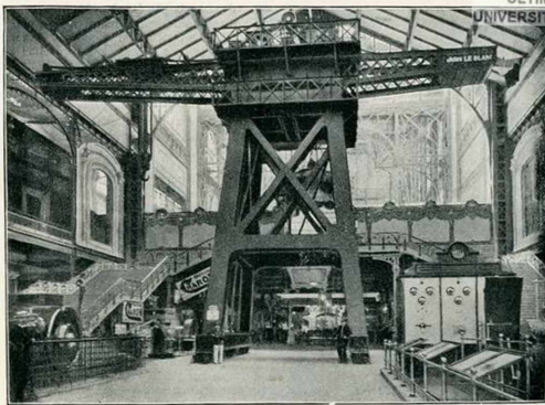
LA GROS TITAN ÉLECTRIQUE QUI A SERVI À METTRE EN PLACE LES MACHINES EXPOSÉES DANS LA SECTION FRANÇAISE.
